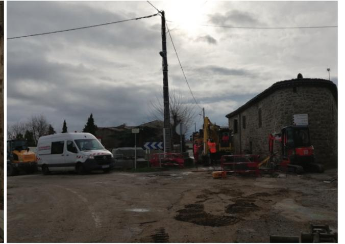
La fin du mois d'avril a vu le démarrage des travaux préparatoires pour le traitement de la surface, sous la maîtrise d'ouvrage de la commune de Quintenas : démolition des trottoirs, préparation des terrasses du bar-tabac-presse et de la pizzeria, pose des bordures, réalisation des bétons désactivés. Les enrobés seront réalisés dans la deuxième quinzaine de juin rendant ainsi la Grande Rue libre à la circulation.
