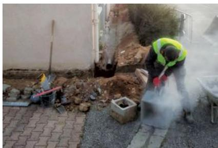
À la suite du contrôle effectué par le service d'assainissement d'Annonay Rhône Agglo, la salle polyvalente présentait des non-conformités quant au raccordement des eaux pluviales. La reprise des écoulements a été réalisée afin de répondre aux exigences réglementaires. Ce chantier a été entièrement réalisé par les employés communaux. Dorénavant, la collecte est
