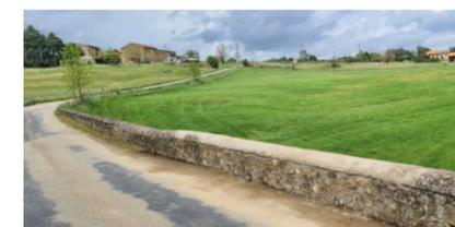
Le parapet du pont de Tartaras a été réparé par l'entreprise LBP Maçonnerie de Quintenas. Depuis un accident, il y a plusieurs années, le parapet côté aval risquait de s'effondrer. Sa consolidation devenait urgente.
